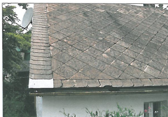
Fot. 2 Płyty azbestowo-cementowe płaskie
