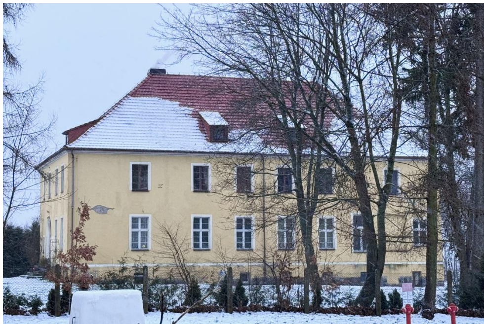
Fot. 2 Pałac w Osiekach Bytowskich (fot. Karina Wiśniewska)
