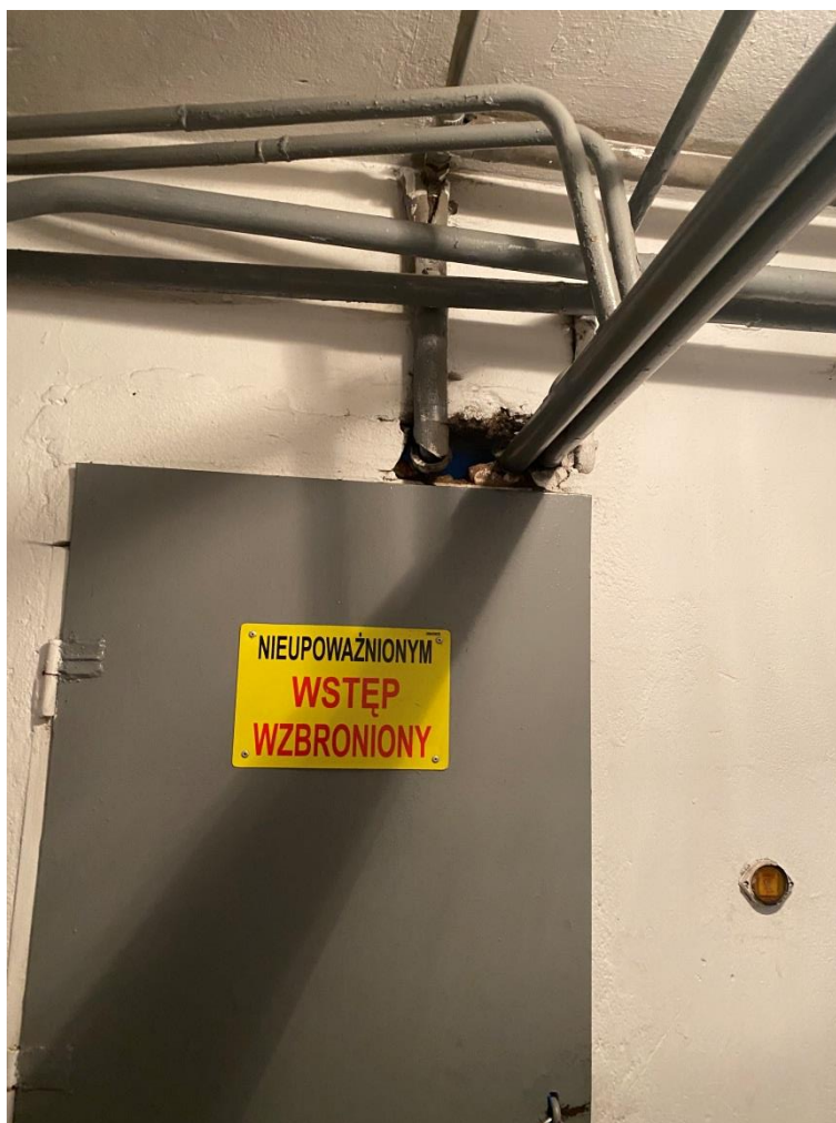
Zdj. 2 – drzwi do wymiany z kotłowni oraz przejścia instalacyjne do kotłowni do wykonania
